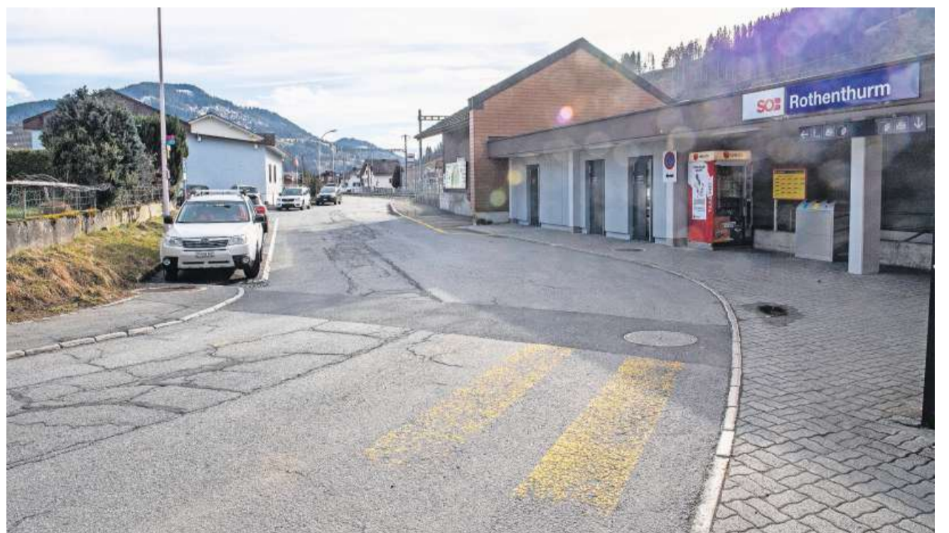
Die in die Jahre gekommene Bahnhofstrasse in Rothenthurm soll saniert werden. Die Gemeinde kauft der SOB zwölf Parkplätze auf der linken Strassenseite ab.
